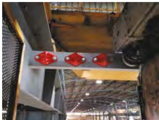
**Fabrication spéciales** : 3 points d'ancrage pour échelle d'évacuation à corde
